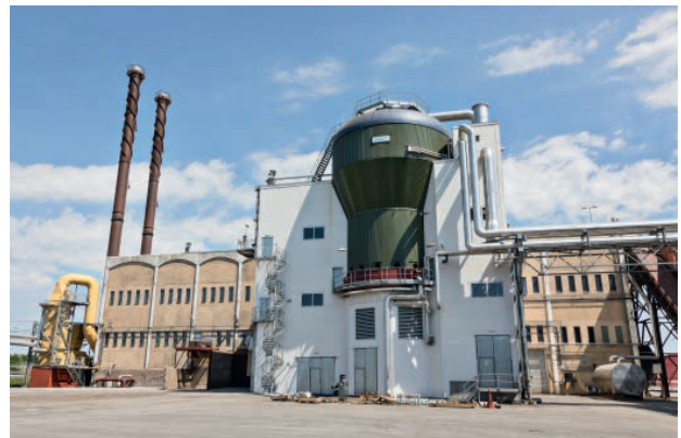
Werk Örtofta: Verdampfungstrockner.
