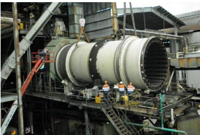
Einbau der Trocknungstrommel für Zucker
