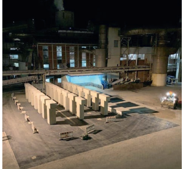
Neubau der Schnitzelpressenstation in Nordstemmen.
